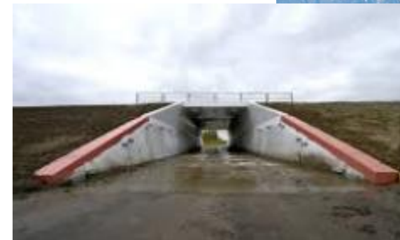
Onder wegen, viaducten
